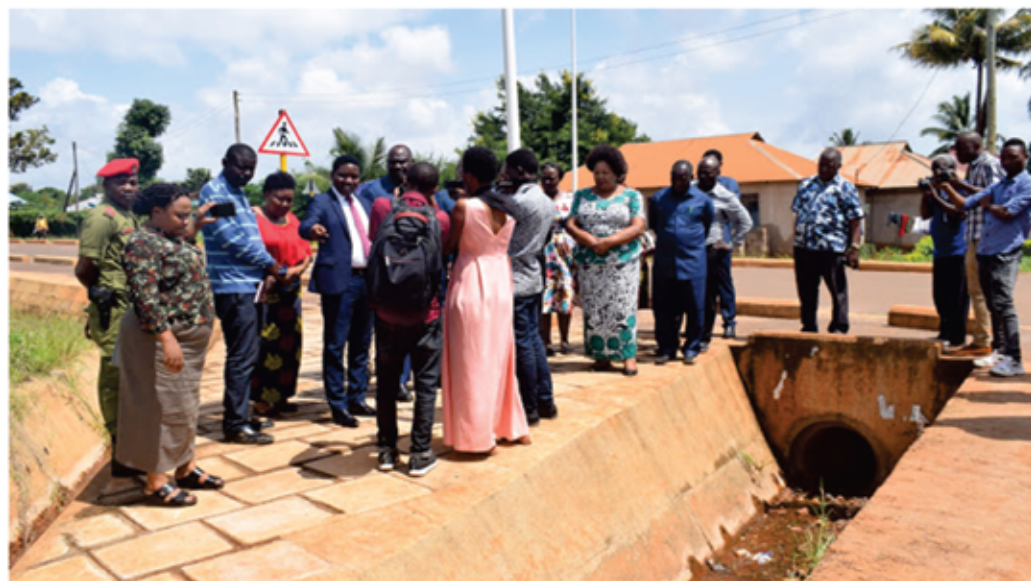
Waziri wa Nchi OR-TAMISEMI Mh. Selemani Jaffo (aliyejaa suti na tai) akikagua ujenzi wa mfereji wa maji katika barabara ya Nanenane Manispaa ya Morogoro.
