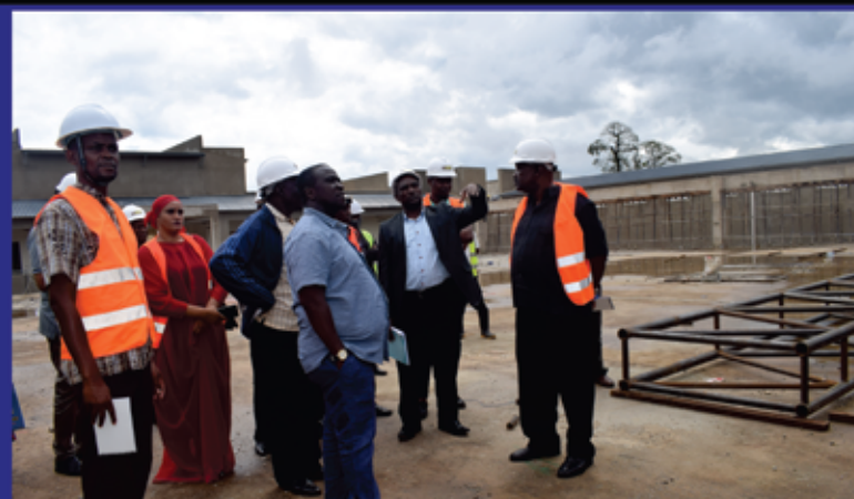
Wajumbe wa Kamati ya Mipango Miji na Mazingira Manispaa ya Morogoro wakiwa katika ukaguzi wa Mradi wa ujenzi wa soko kuu la kisiasa
